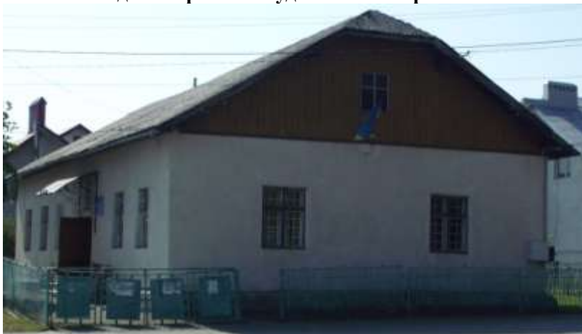
Фото 1. Приміщення Угринівської сільської ради.
