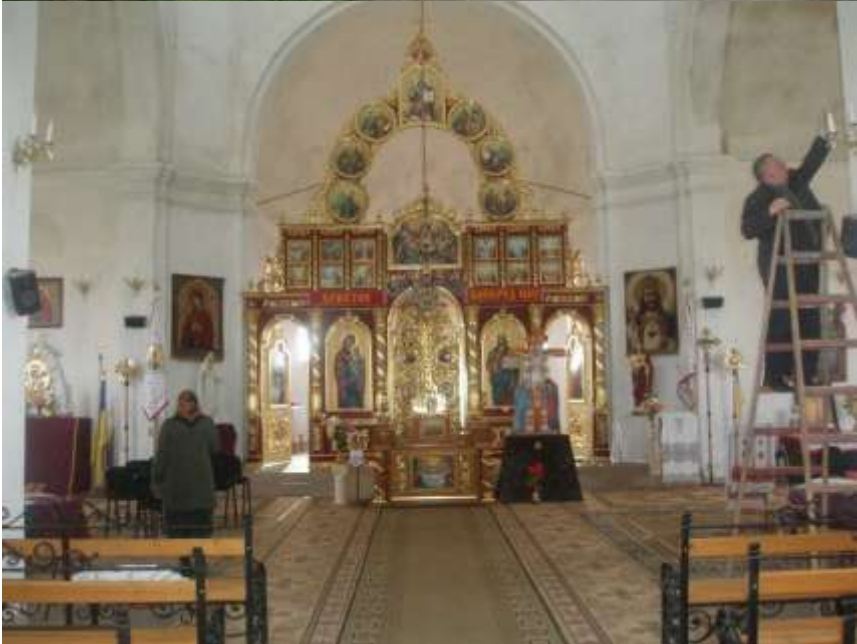
Фото. 6. Будівництво нової угринівської церкви.
