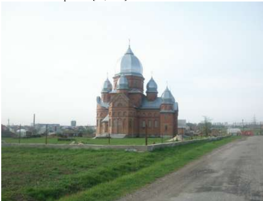
Фото 18. Будівництво нової Угринівської церкви (1994-2004рр.).
